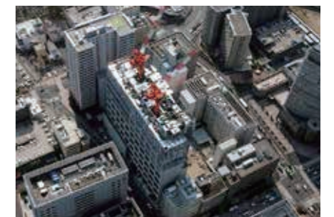
大宮JPビルディング 建設現場
