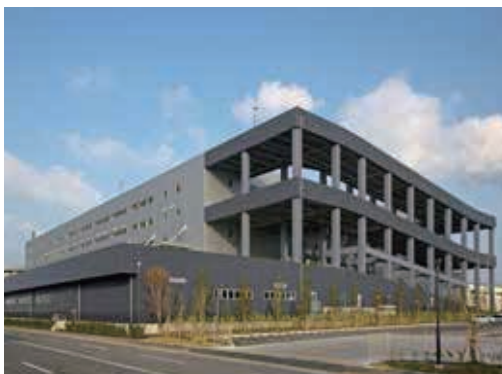
川崎東郵便局/南東面外観
