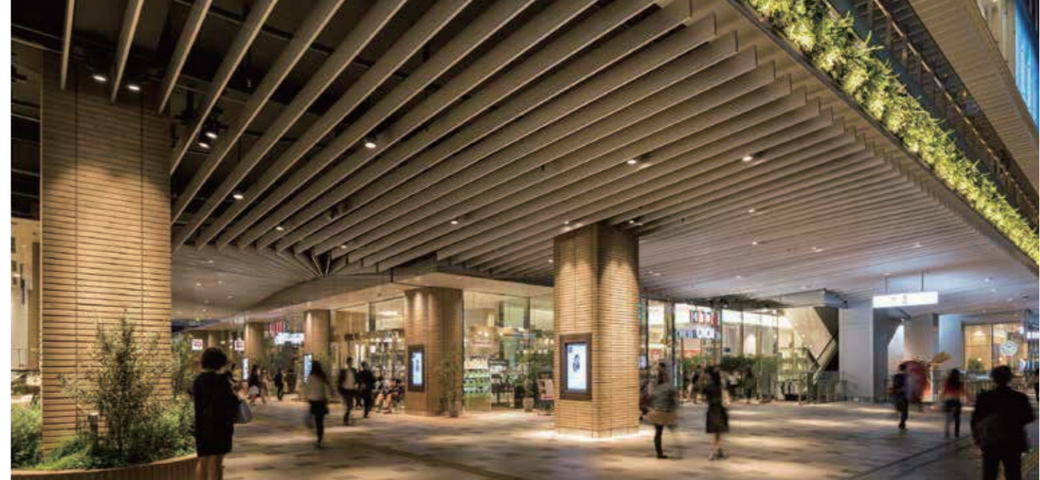
博多駅前広場から建物中央を貫通する通路
