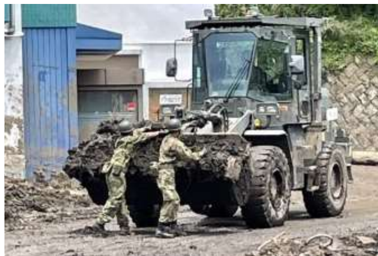
道路啓開活動(第1施設大隊)
