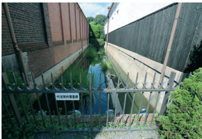
倉敷代官所の掘跡（倉敷市本町）
