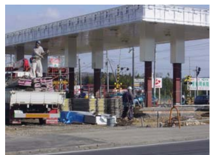
(建設中のセルフスタンド)
