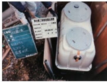
合併処理浄化槽の設置工事
