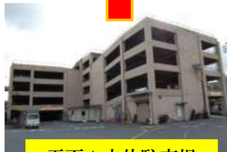
平面+立体駐車場
