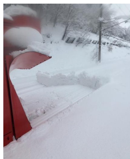
1/12 上野幌付近の除雪作業
