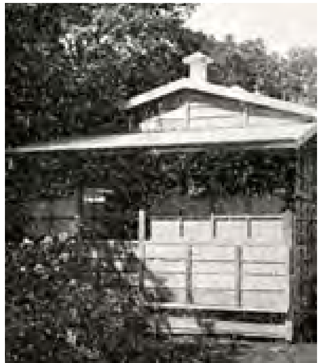
臨時の作業所(麻布富士見町)
