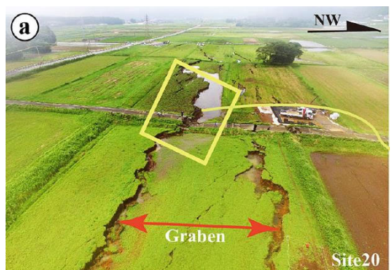
ruptureの例 Fig. 9a
