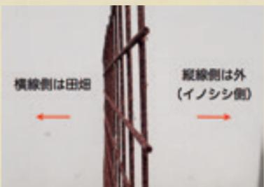
柵の外側に縦線、内側に横線がくるように設置
