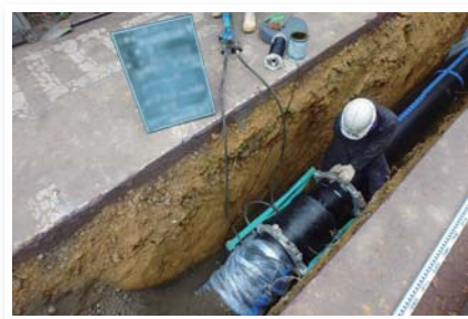
老朽化した水道管の更新工事
