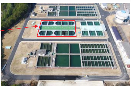
緑ヶ丘浄水場急速ろ過池設備改良工事
