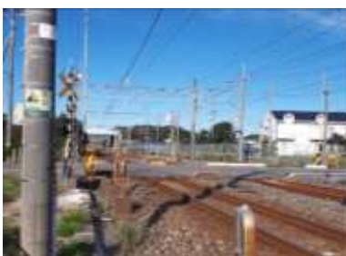
実際に設置した写真
