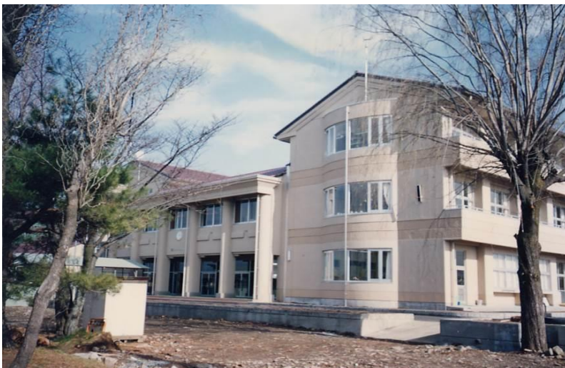
佐久市立中込中学校管理棟新築工事 〔構 造〕鉄筋コンクリート造 3階建
