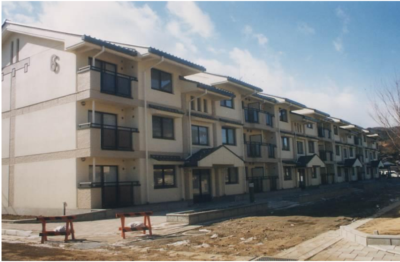
県営住宅泉団地6号棟建築工事 〔構 造〕鉄筋コンクリート造 3階建
