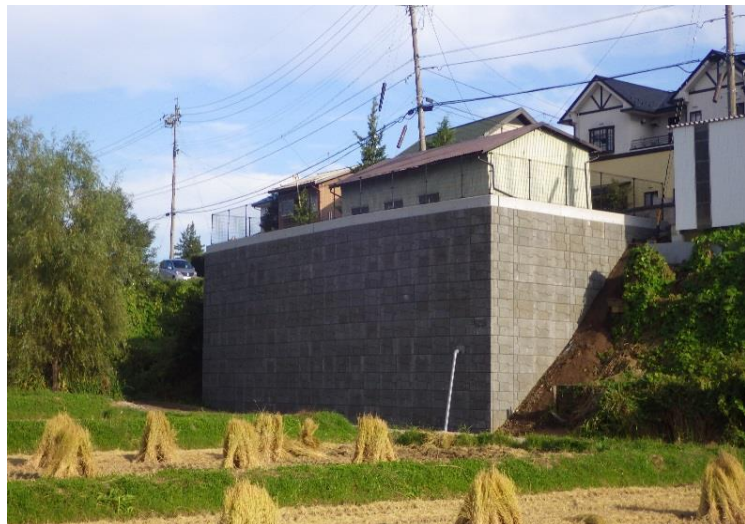
K様邸擁壁改修工事
