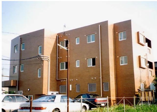
(仮称)K駅前共同住宅新築工事 〔構 造〕鉄筋コンクリート造3階建
