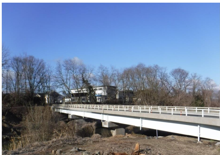
藤ノ木橋 橋梁補修工事
