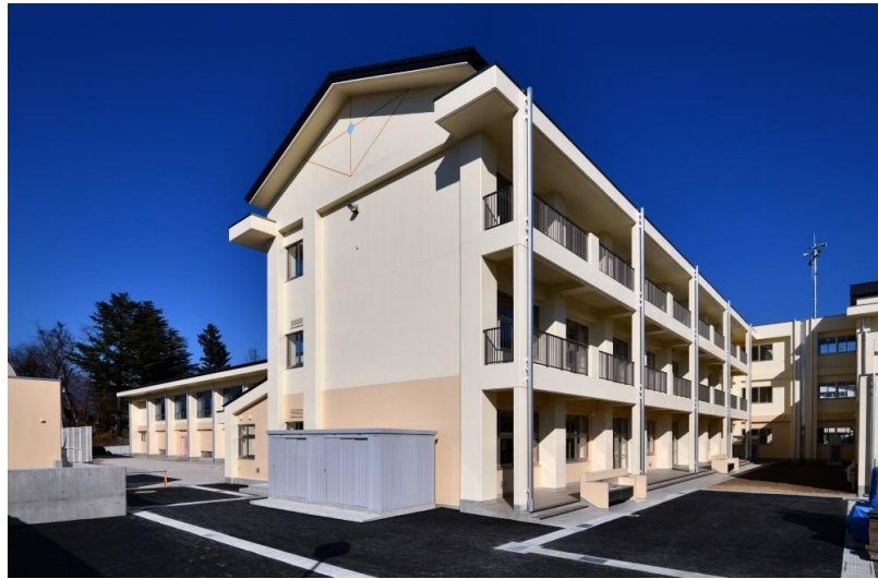
佐久市立岩村田小学校 管理特別教室棟・屋内運動場等 改築(本体)工事 〔構造〕鉄筋コンクリート一部鉄骨造 〔規模〕延面積 4,568.79㎡
