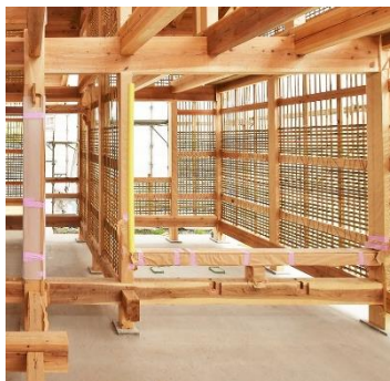
開放的な床下（石場建て）
