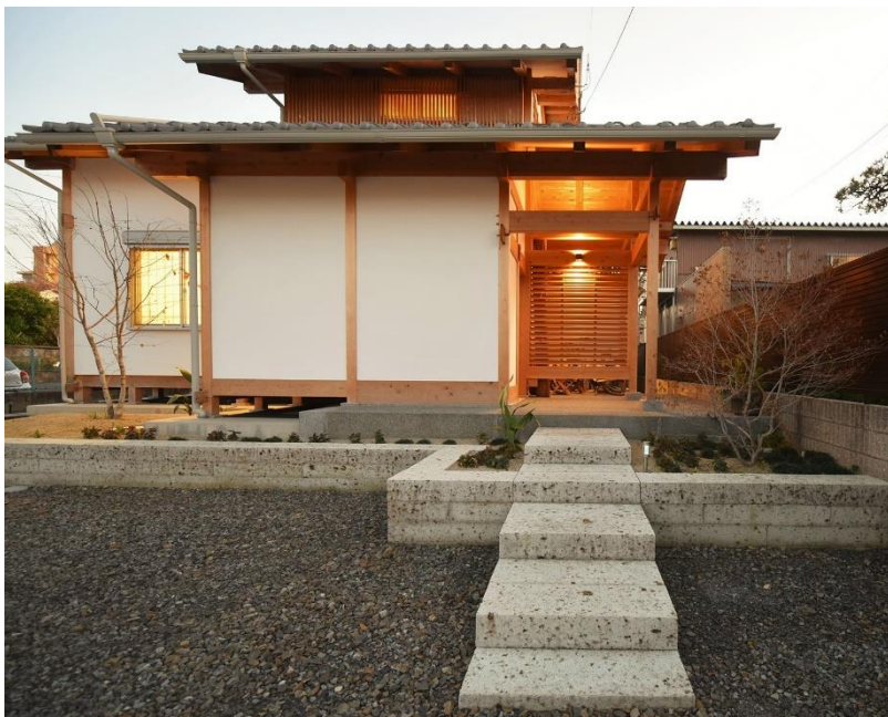
準防火地域内の市街地の中での伝統的な土壁による真壁・石場建ての外観
