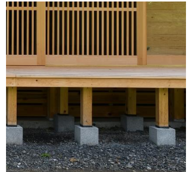
開放的な床下（石場建て）
