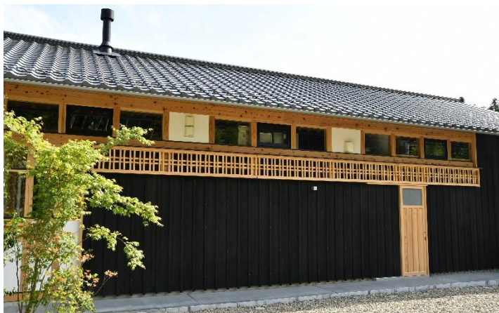
水平に連続した高窓による通風への配慮
