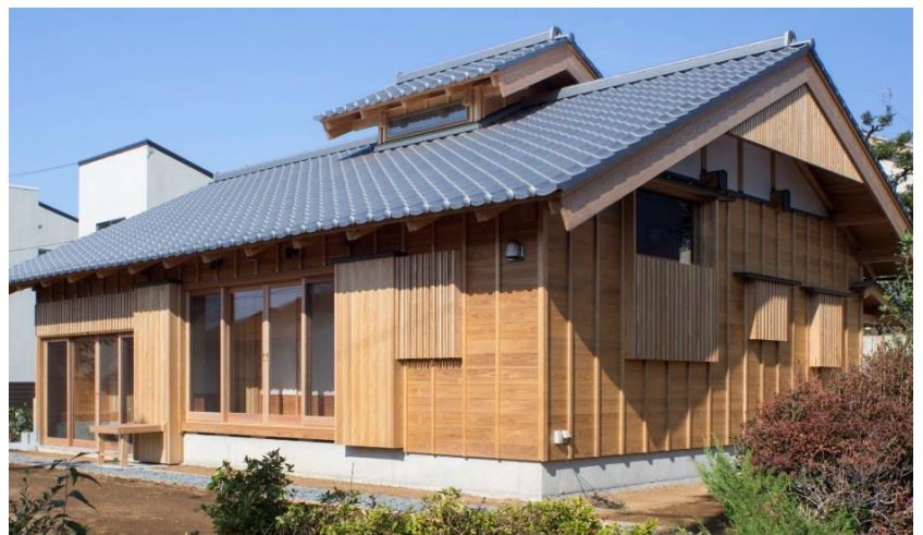
腰屋根のある日本瓦の屋根と板壁が特徴的な外観
