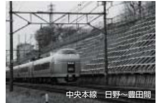
中央本線 日野～豊田間 切取りの面工 (吹付枠工)
