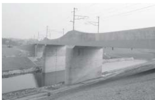
東北線平泉～前沢間衣川橋りょう
