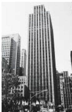
▶ニューヨーク事務所 (マンハッタンの中心、ロックフェラープラザビル)
