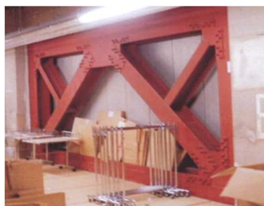
鉄骨ブレースによる補強
