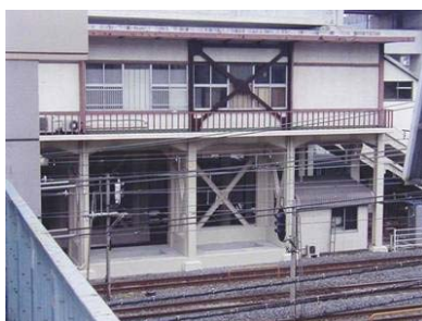
鉄骨ブレースによる補強
