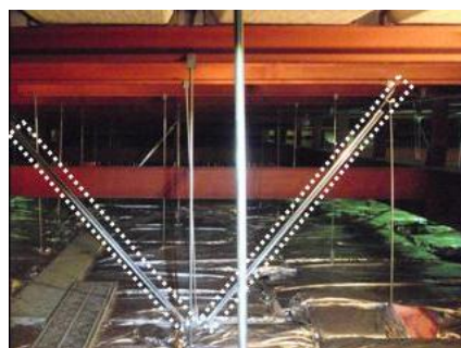
東日本大震災による天井材の落下と斜材による補強イメージ
