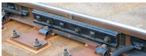
改良前の接着絶縁継目
