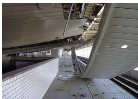
東日本大震災による天井材の落下と斜材による補強イメージ
