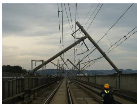
東日本大震災による電化柱の損傷例と補強イメージ
