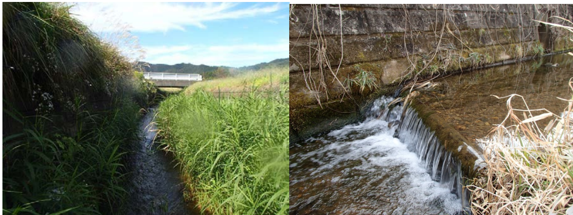
図 2.6 調査地（藤井川長町橋下）を下流からのぞむ全景（左側：2016 年 10 月 12 日撮影）および調査地上流側の河川工作物（右側：2016 年 12 月 2 日撮影）
