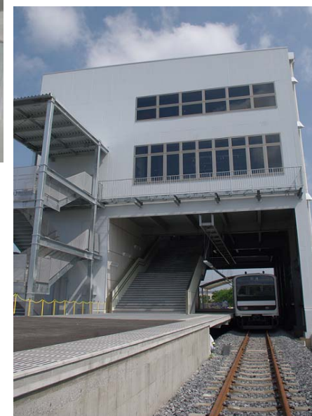
Smart Station実験棟全景
