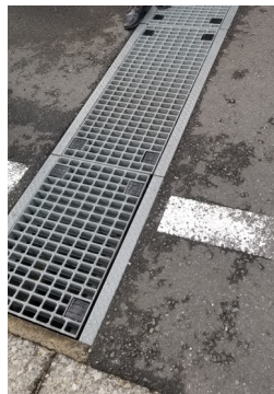
雨水対策のグレーチング設置で排水力アップ
