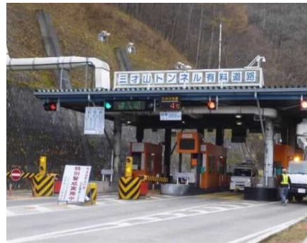
上田側から見る三才山料金所
