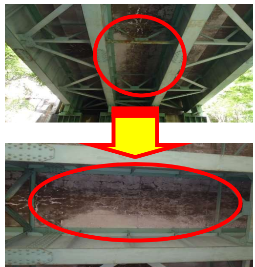
写真-1 施工前床版の状況
