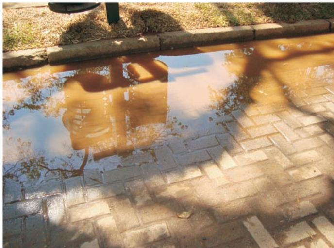
Figura 1 - Juntas colmatadas
