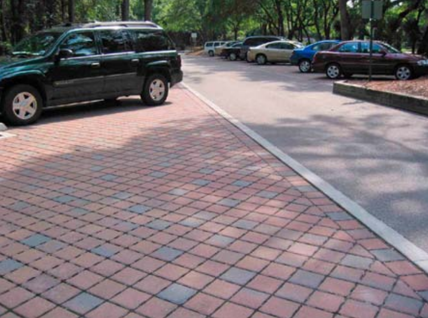
Figura 2 - Estacionamento utilizando pavimento permeável
