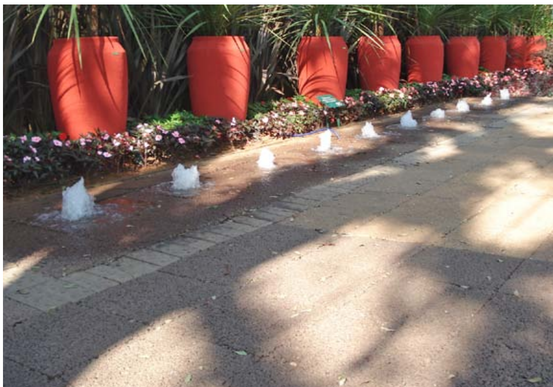
Figura 5 - Pavimento permeável com revestimento de placas de concreto
