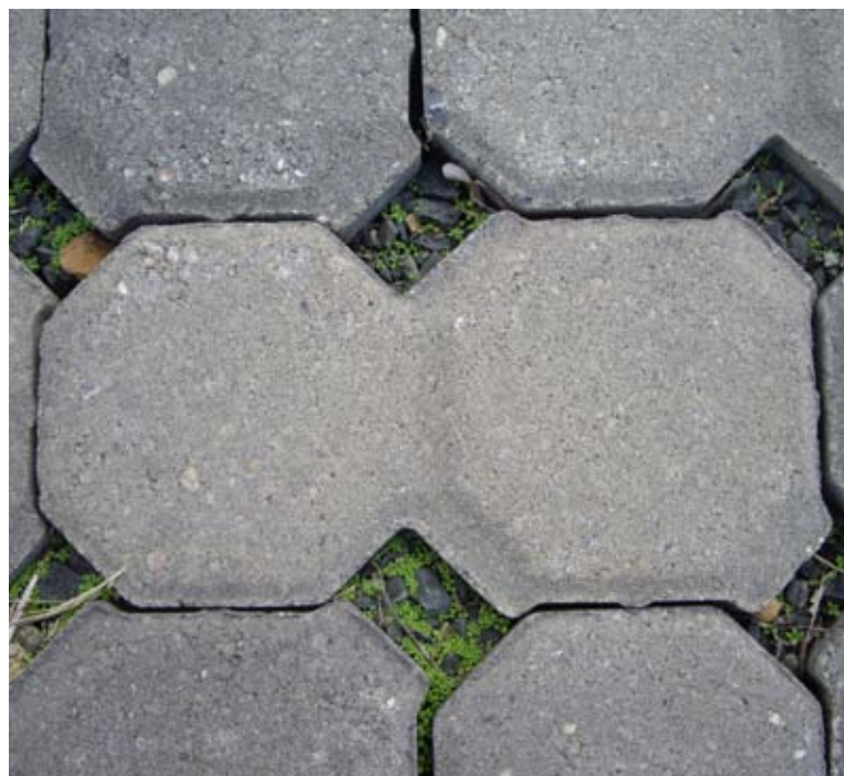
Figura 15 - Crescimento de vegetação nas juntas de pavimentos permeáveis
