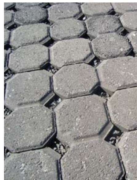
Figura 13 - Note que o material de rejunte fica 5 mm abaixo do topo da peça.
