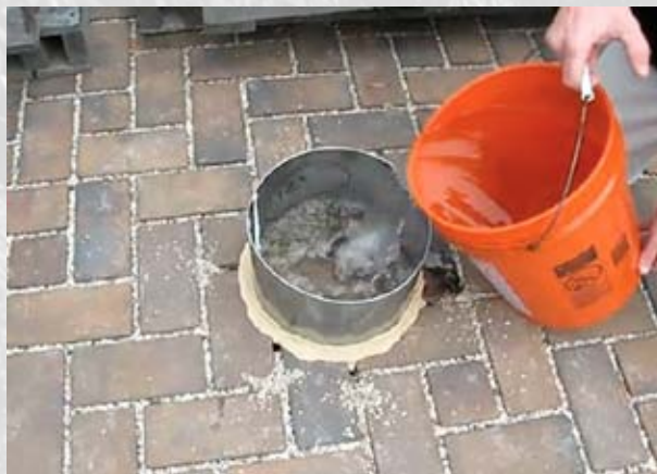
Figura 16 - Ensaio para determinação do coeficiente de permeabilidade de um pavimento permeável
