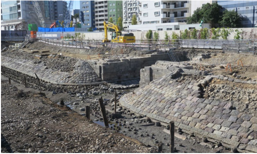
現在の橋梁部の様子
