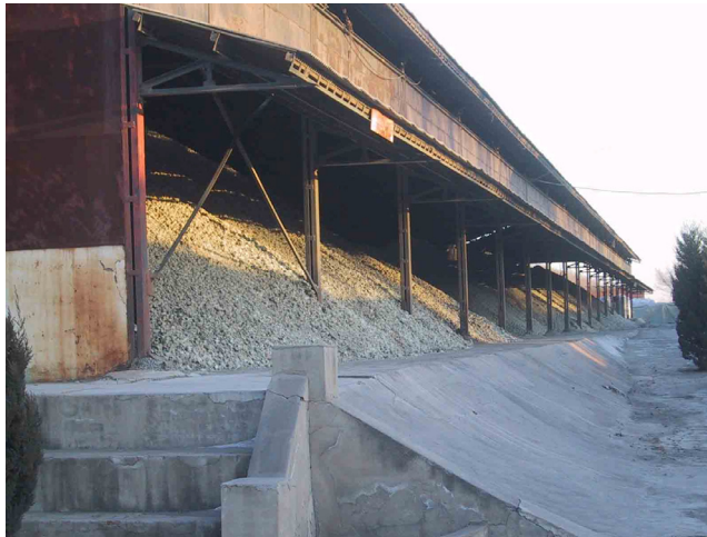
写真 3.4-18 乾燥原鉱置場（旧工場）
