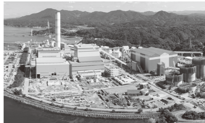
二号機を建設中の三隅発電所
