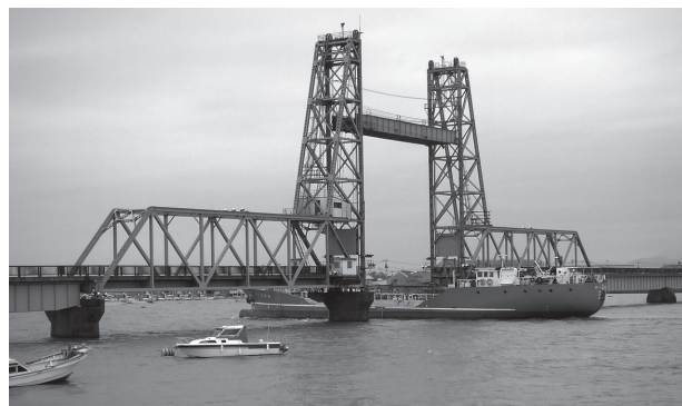
写真-1 筑後川昇開橋（著者撮影）
