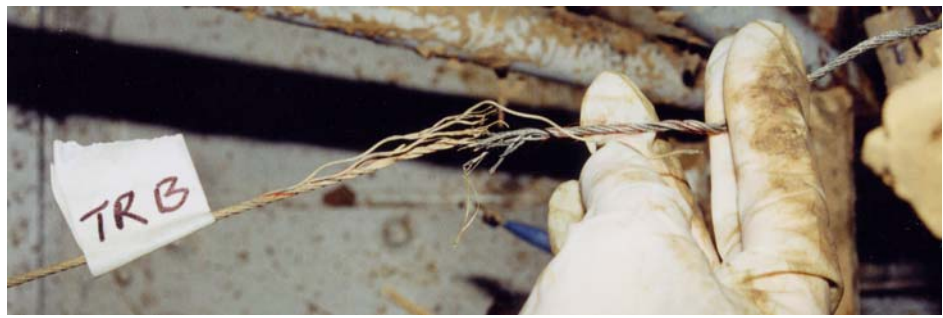
Figura 28.3 – Daños al cable TRB
