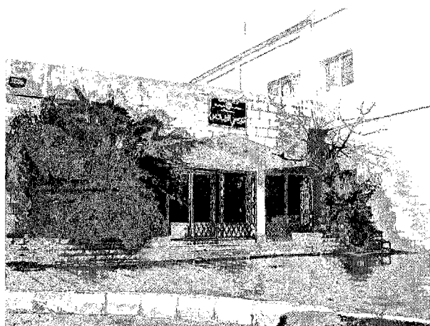
1. マザール・コンプリヘンシブセンター
