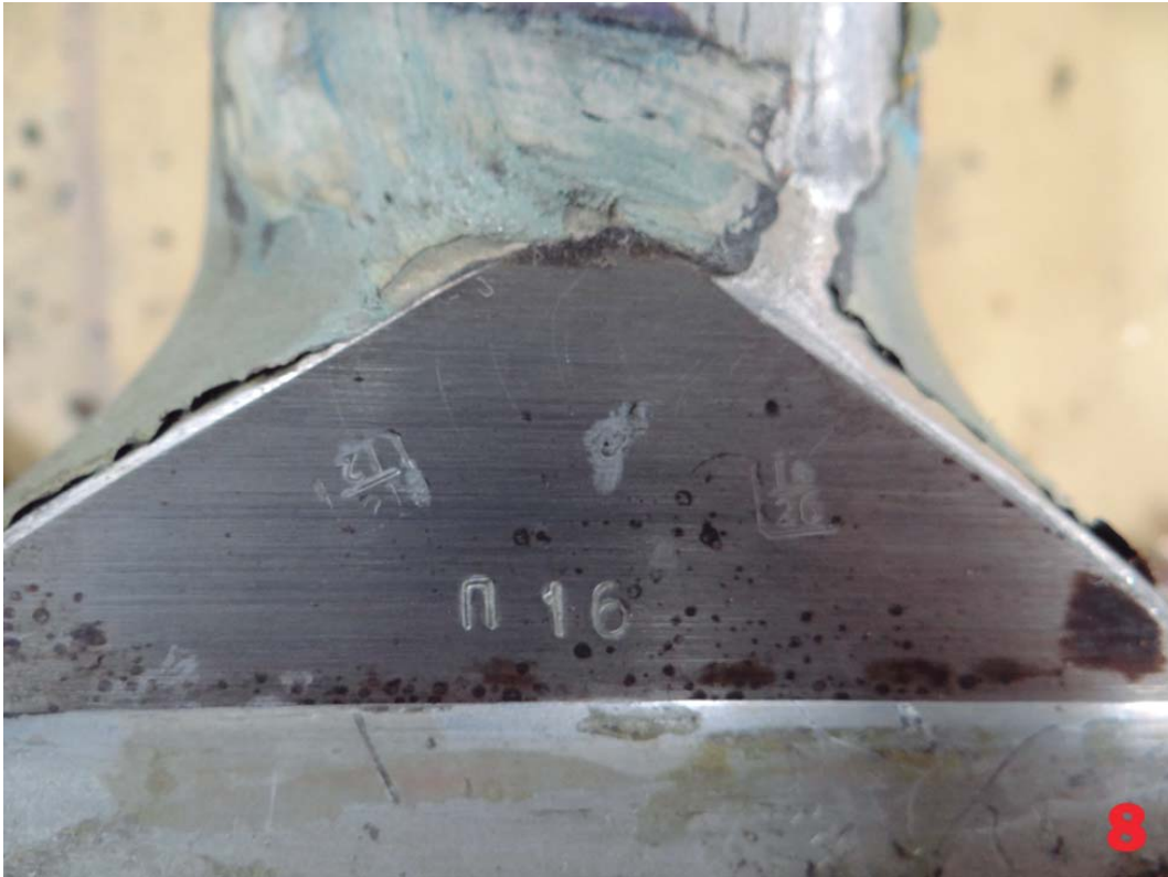
Identificación de soporte estructural de sujeción de pala N 16
