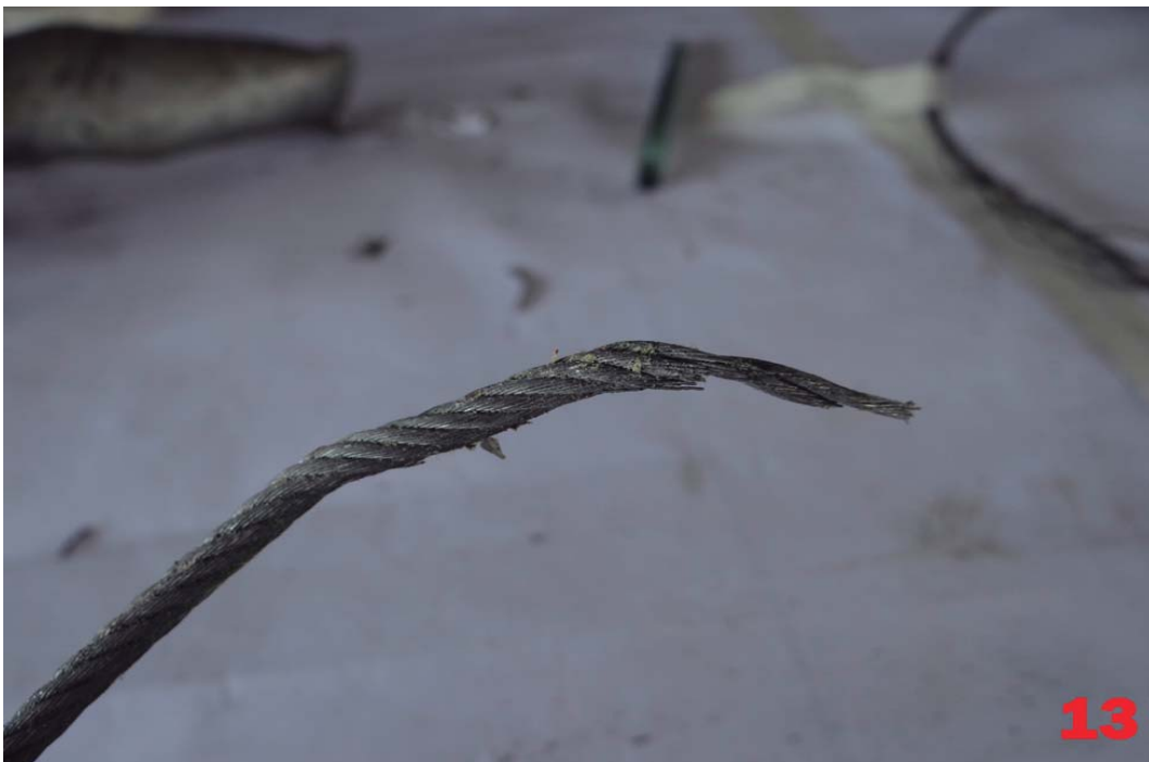
Tercer cable fracturado, que muestra rotura de los cables espirales más distanciado, correspondiendo a un ángulo más agudo de rotura.
