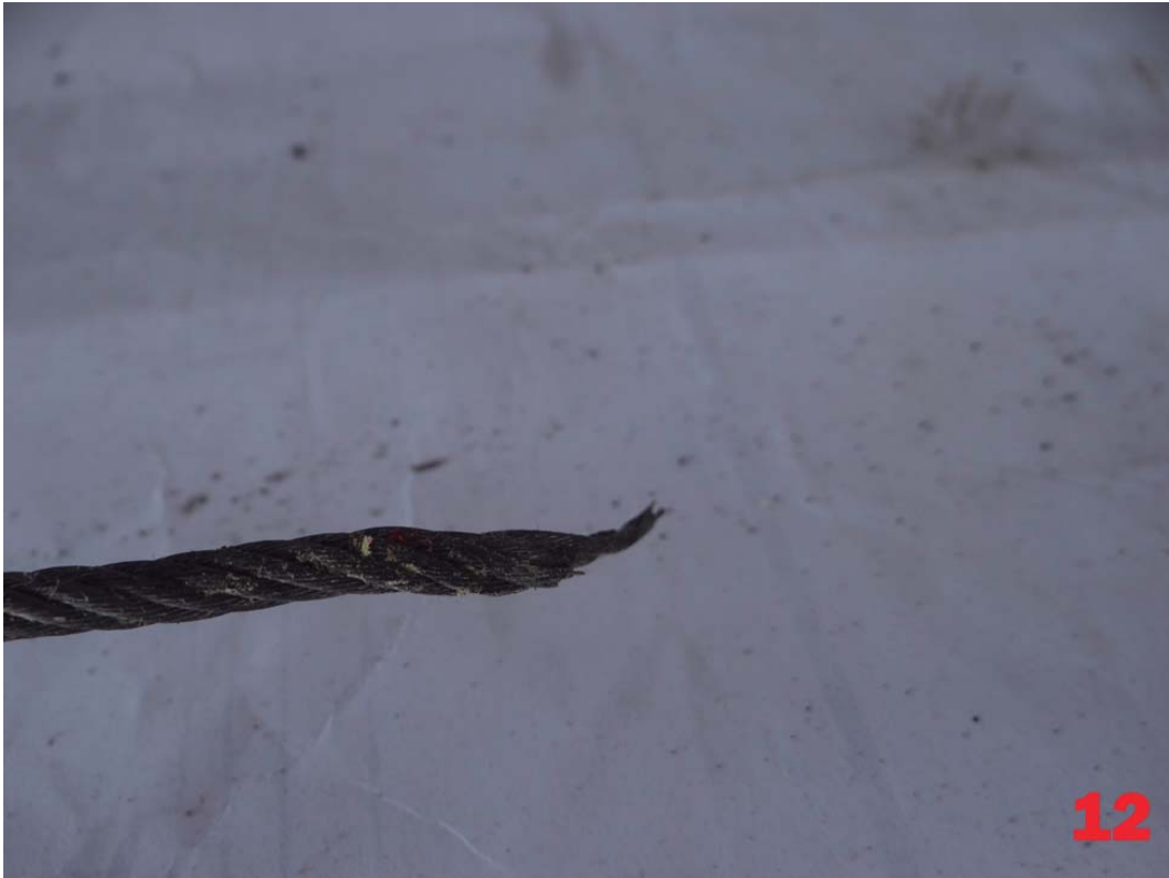
Segundo cable fraccionado y en rotura de forma diagonal, que se encontró adherido al eje de transmisión de potencia.
