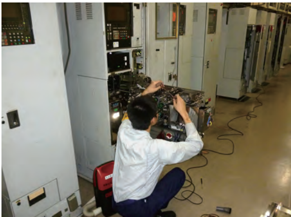
券売機の点検
