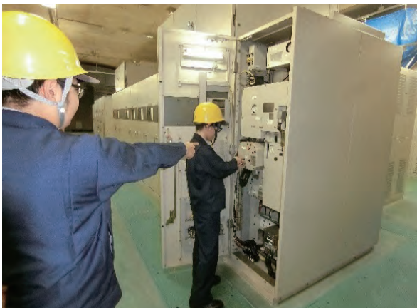
C-GIS(ガス絶縁)断路器操作
