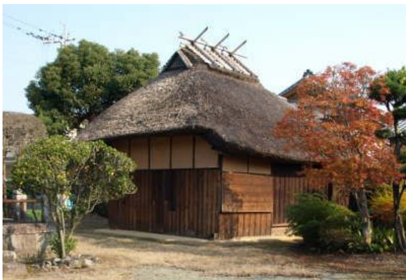
山樞窩。筑後市大字 水田242-1 和泉は11年間ここに 蟄居した。
