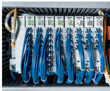
CPX-E и пневмоострова VTUG с IO-Link® используются для управления системой.
