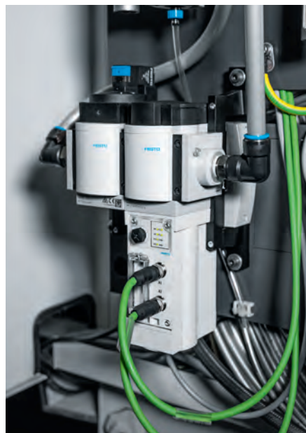
Предустановленные параметры падения давления позволяют обнаруживать утечки автономно.
