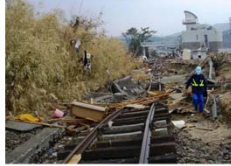
J【道床流失】 のびら (仙石線 野蒜構内)
