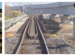
K 【橋りょう橋脚傾斜】 (水郡線 水戸～常陸青柳間)
