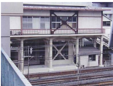
鉄骨ブレースによる補強
