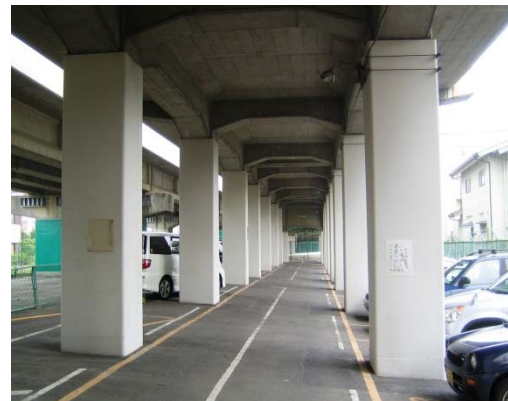
鋼板巻きによる高架橋柱の耐震補強
