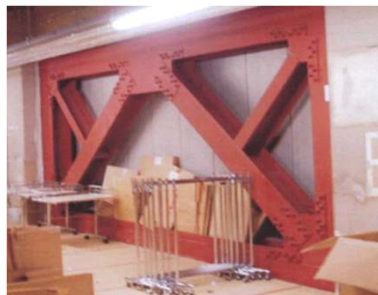
鉄骨ブレースによる補強
