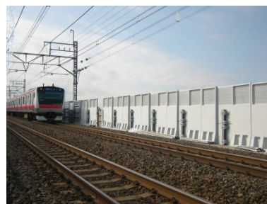
京葉線 潮見～新木場間
