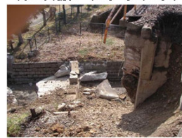
E 【土留壁傾斜・道床流失】 (奥羽本線 庭坂～赤岩間)
