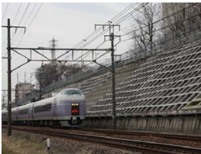
切取りり面工（吹付砕工）
