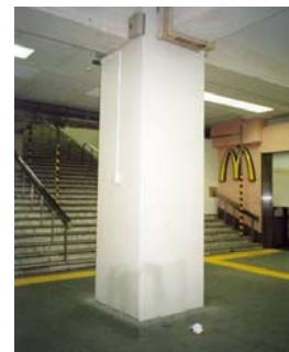
鋼板巻きによる柱の補強
