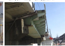
L 【橋桁のずれ】 (鹿島線 碓方～鹿島神宮間)
