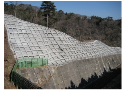
自然斜面防護工（吹付砕工）
