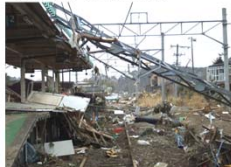
J【道床流失】 のびら (仙石線 野蒜構内)
