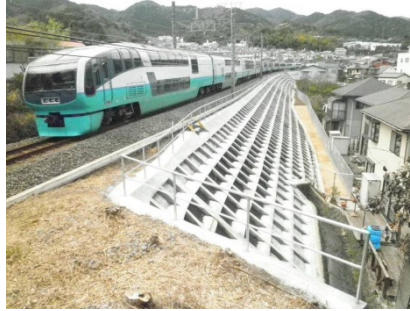
盛土りり面工（吹付砕工）
