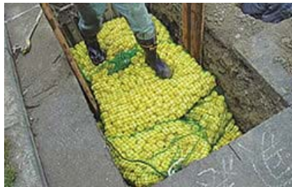
「ECOボール」を利用した導管工事
