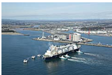
日立LNG基地
