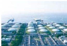
袖ヶ浦LNG基地
