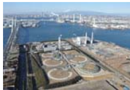
扇島LNG基地
