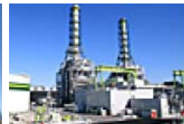
川崎天然ガス発電 (株)
