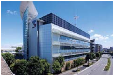
アースポートの建物外観（改修後）
