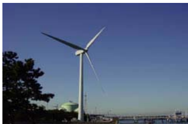
袖ヶ浦LNG基地内の風力発電設備
