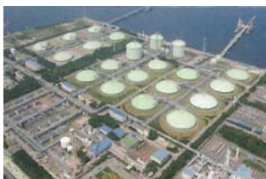
袖ヶ浦LNG基地
