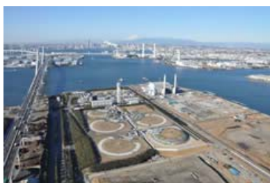
扇島LNG基地
