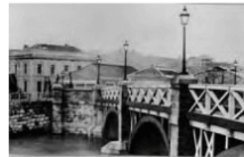
松山/弁天橋のガス灯
