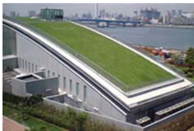
「がすてなーに ガスの科学館」の屋上
