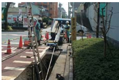
ガス管を推進するための立坑
