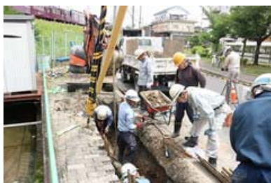
復旧作業の様子
