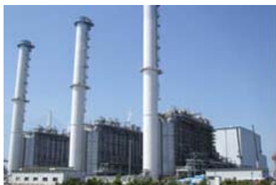
現在の扇島パワーステーション
