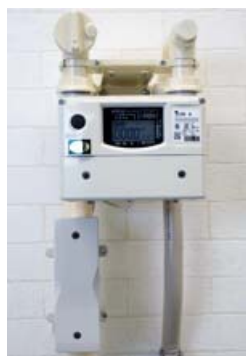
超音波式ガスメーター（上）とPHS通信端末（下）
