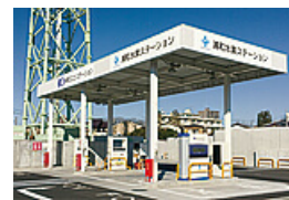
浦和水素ステーション
