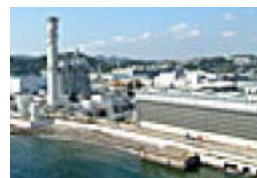
(株) 東京ガス横須賀パワー
