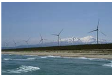
遊佐風力発電所の様子
