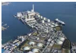
根岸LNG基地
