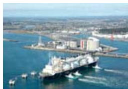
日立LNG基地
