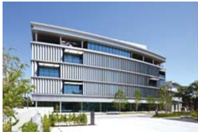
アースビル立川の建物外観
