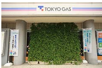
壁面や窓際に植物を生育させているTG熊谷ビル
