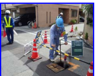
断・通水作業
