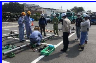
配水場内継手講習会
