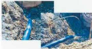
水道用ポリエチレン管 電気融着接合 地震後、屈曲追従している管
