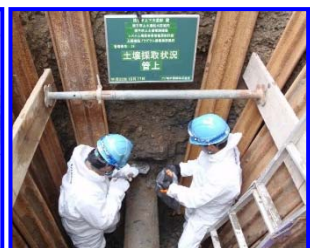
埋設環境調査
