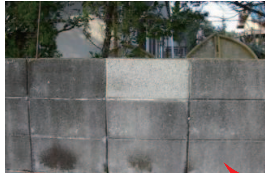
ナノティオテクト施工直後 2007年1月
