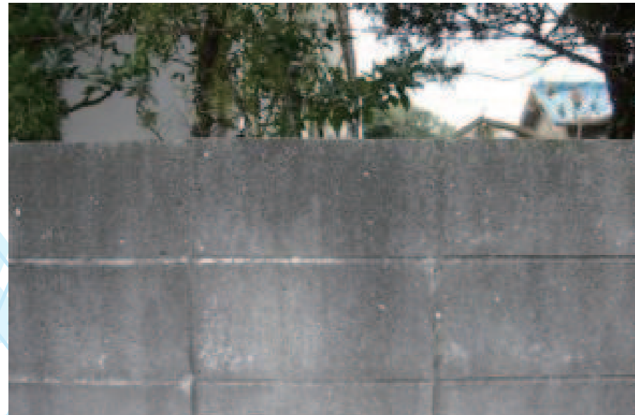
初期状態 施工前に洗浄し ナノティオテクトを施工
