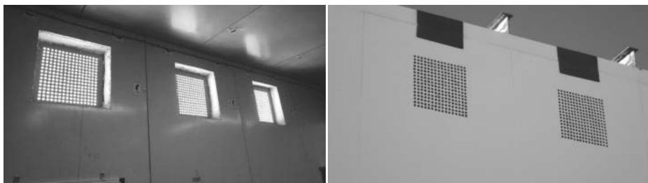
写真Ⅲ.3.2.1.1.1.1-1 小屋外壁の改造(原図はカラー)
