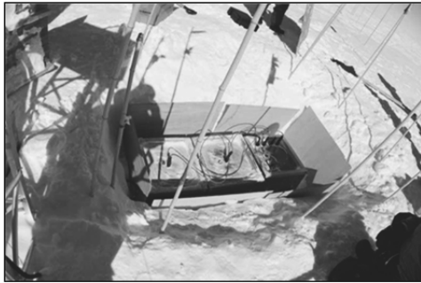
写真Ⅱ．2.2.6-1 雪洞壁補強後
