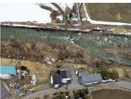
唐地線橋梁新設工事の予定箇所
