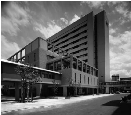
本館・図書館棟 背後に総合研究棟を望む
