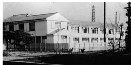
愛泉寮木造本館（昭和29年9月竣工）
