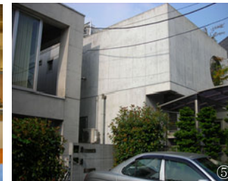
①屋上。ヤシ殻マットは(株)クレアテラのガーデンマット。風化しているが、湿り気があるだけで断熱効果は抜群とのこと。②ドレインは蓋があるため詰まっていなかったが、耐根シート、灌水装置などの兼ね合いで土留めを作る③キッチン裏側のバルコニー④2階ダイニング。左壁上部が給気用換気扇。下の窓を開ければ煙は問題ない。台所のレンジはよく機能している⑤西側壁面。日が良く当たるので、この部分に断熱を施したい。隣家の影になっている部分には、すでにガルスパンが貼ってある。
