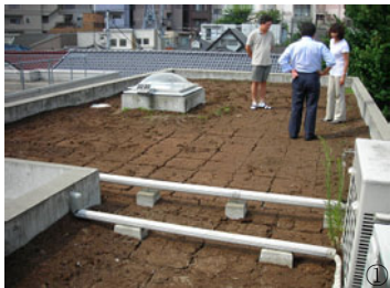
①屋上。ヤシ殻マットは(株)クレアテラのガーデンマット。風化しているが、湿り気があるだけで断熱効果は抜群とのこと。②ドレインは蓋があるため詰まっていなかったが、耐根シート、灌水装置などの兼ね合いで土留めを作る③キッチン裏側のバルコニー④2階ダイニング。左壁上部が給気用換気扇。下の窓を開ければ煙は問題ない。台所のレンジはよく機能している⑤西側壁面。日が良く当たるので、この部分に断熱を施したい。隣家の影になっている部分には、すでにガルスパンが貼ってある。
