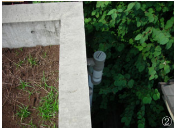
①屋上。ヤシ殻マットは(株)クレアテラのガーデンマット。風化しているが、湿り気があるだけで断熱効果は抜群とのこと。②ドレインは蓋があるため詰まっていなかったが、耐根シート、灌水装置などの兼ね合いで土留めを作る③キッチン裏側のバルコニー④2階ダイニング。左壁上部が給気用換気扇。下の窓を開ければ煙は問題ない。台所のレンジはよく機能している⑤西側壁面。日が良く当たるので、この部分に断熱を施したい。隣家の影になっている部分には、すでにガルスパンが貼ってある。
