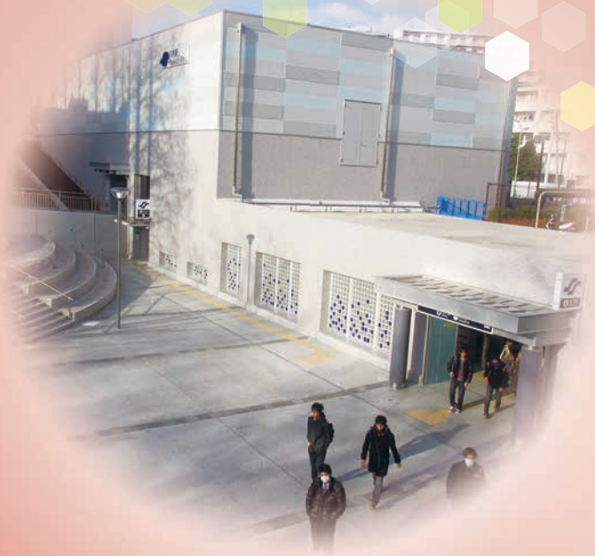
地下鉄 東西線 川内駅
