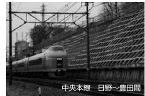
中央本線 日野~豊田間 切取りの面工(吹付砕工)
