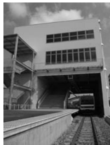
Smart Station 実験棟
