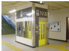
エレベーター
