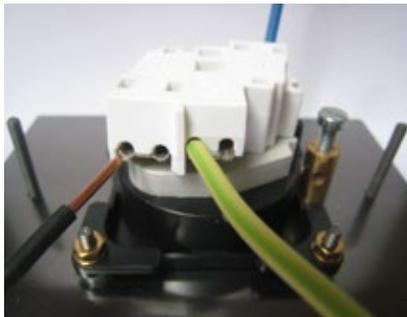
Utiliser du câble rigide de section 2,5 mm<sup>2</sup>
