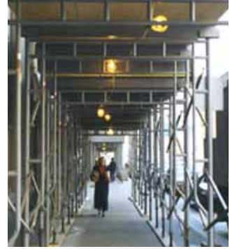
Şekil 19: Iskele altı geçit
