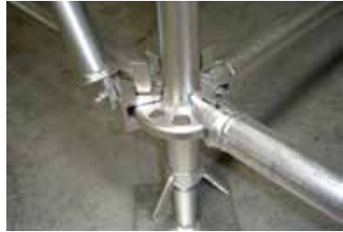
Şekil 16: Çaprazın dikmeye yerleştirilmesi
