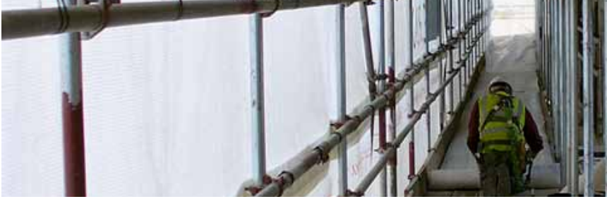
Şekil 22: İskelede kaplama yapılması
