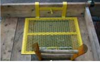
Şekil 12: Merdiven ulaşım açıklığı
