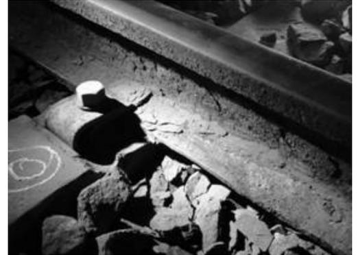
図 1 塩害により腐食したレール
