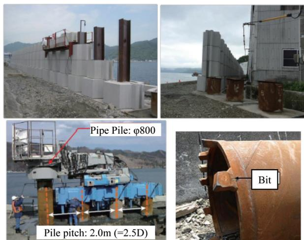
写真8 自立式プレキャスト防潮堤施工状況
