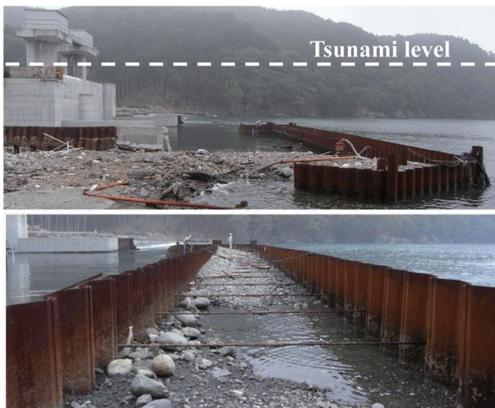
写真2 鋼矢板2重壁の津波被災例
