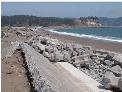
写真1 海岸堤防の被災事例
