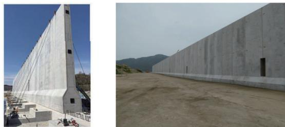
写真7 逆T型プレキャスト防潮堤施工状況
