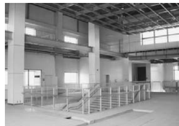
図4 3階橋上駅コンコース
