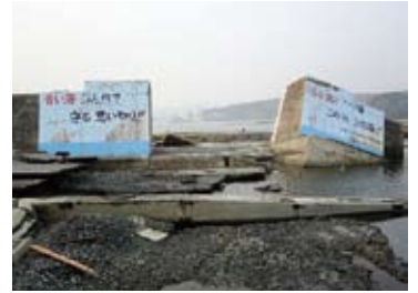
東日本大震災 南三陸町の防潮堤 (2011年3月、著者撮影)
